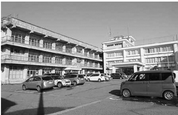
仮称生涯学習センターの建設が予定される旧小出庁舎
