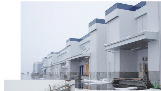
◀現在、工場棟を拡張する第2期工事中(来春5月に完成予定)
