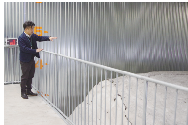
▲貯蔵量 300トンの雪室(空気循環式) 冷気をカカオ豆熟成用の貯蔵庫に送っています。
