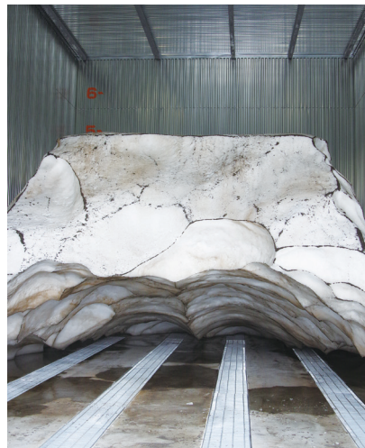
▲貯蔵量 300トンの雪室(空気循環式) 冷気をカカオ豆熟成用の貯蔵庫に送っています。
