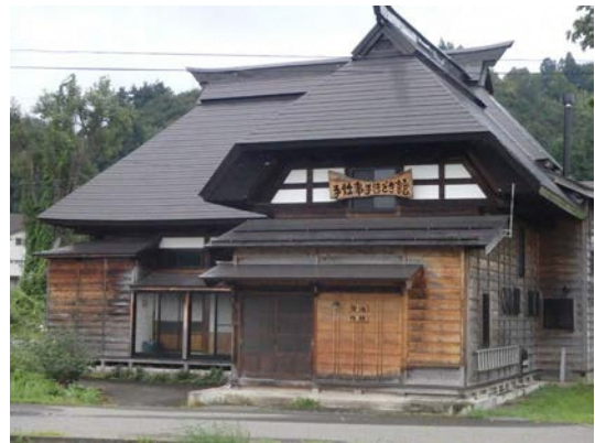
農家民宿として活用されている 手仕事手ほどき館（登録有形文化財）
