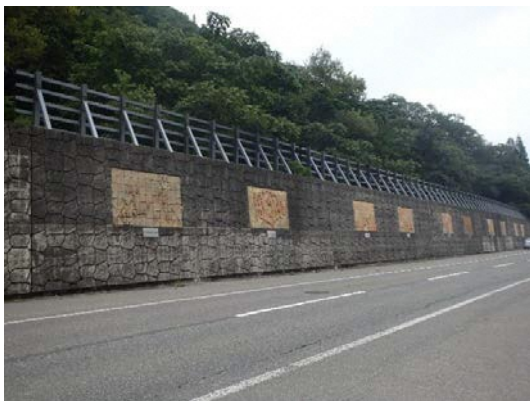
湯之谷焼が埋め込まれた雪崩予防壁 (国道 352 号沿道)
