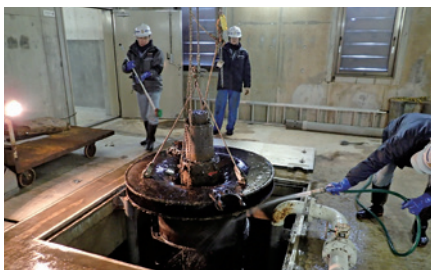
下水道施設の設備清掃
