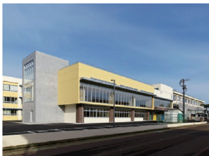
建築施工物件：上川西小学校校舎増築工事
