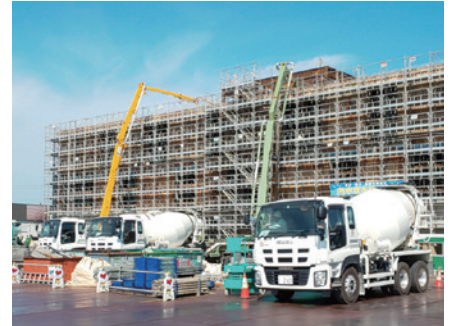
生コン納入の様子
