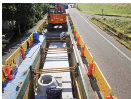
四日町地区雨水管渠布設第3次工事
