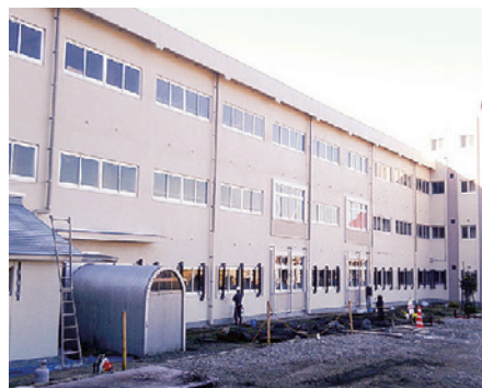
湯之谷中学校校舎改修（第1期）完成
