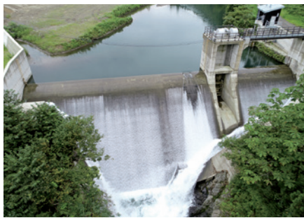
より災害に強い発電ダムへ改修
