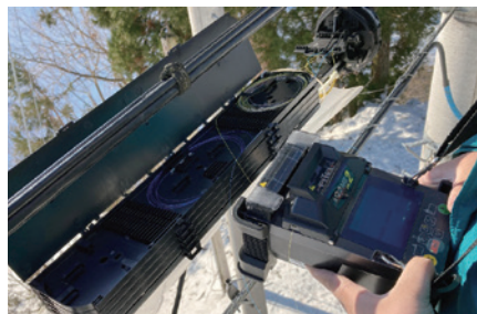
電気通信工事
