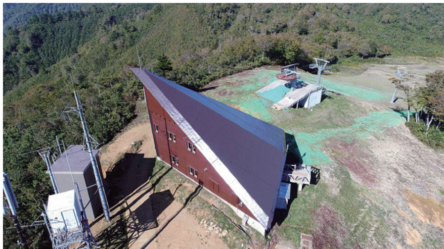
山頂ヒュッテ屋根葺き替え工事 完了
