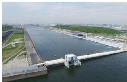
競技場インフラ電気設備工事
