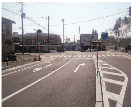
堀之内・小出線街路工完成
