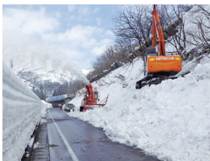
県道除排雪（雪庇処理）
