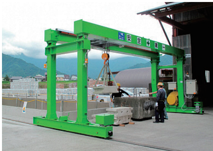
クレーン設置工事
