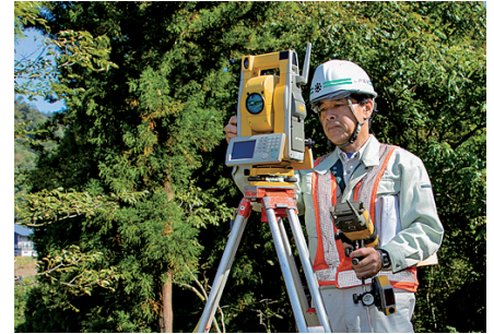
ICT で重機に指示を出します
