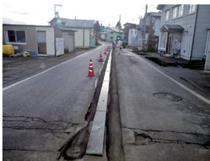
消雪ブロック納入現場
