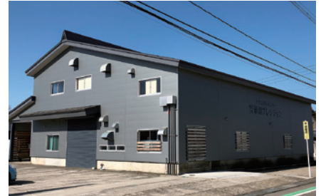
テクニカルセンター外観
