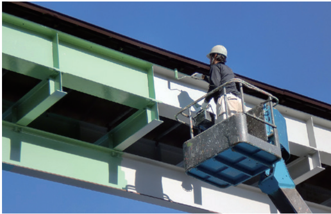
高所作業車にて作業
