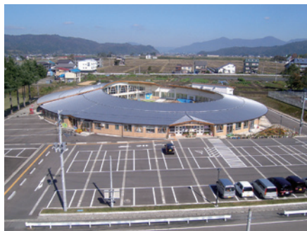
浦佐認定こども園新築工事
