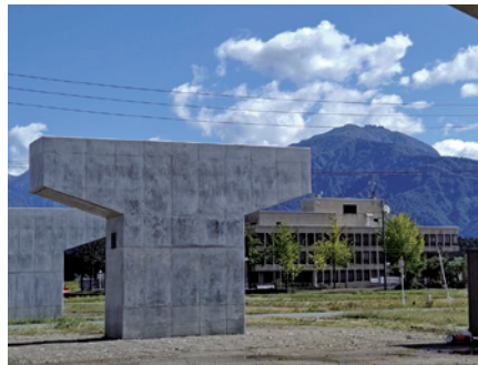
国道17号浦佐バイパス橋脚工事
