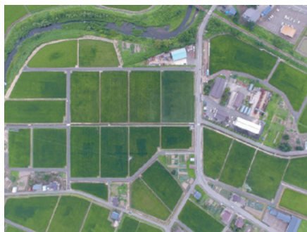
ほ場整備工事
