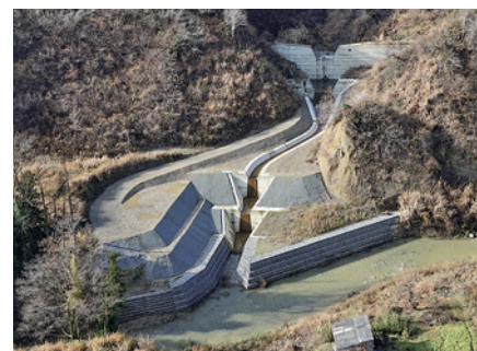
土木施工物件：南平アシ沢外砂防堰堤工事（十二平川工区）
