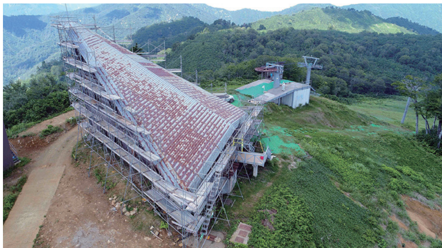
山頂ヒュッテ屋根葺き替え工事 足場組立完了
