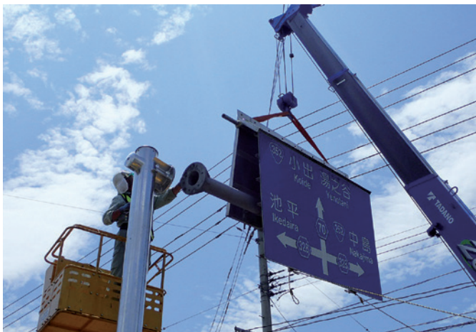
作業風景（重機使用）
