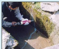
ひび割れの補修
