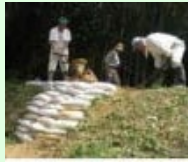
漏水箇所の補修
